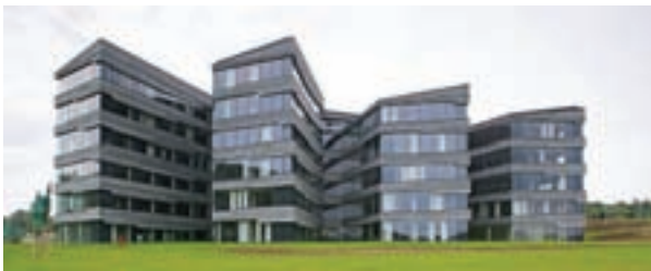
Pannon GSM irodaépülete
